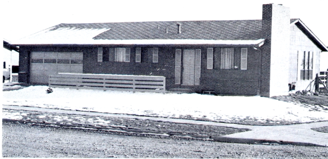
Fig. 8: La sagoma disegnata dalla neve sul tetto di una casa dà un'idea della conduzione - o della mancanza di conduzione - di calore attraverso il tetto. Si noti la neve sul garage non riscaldato.
